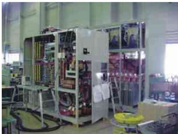
図 4 SBT-EL900（900kW 型）試験風景
