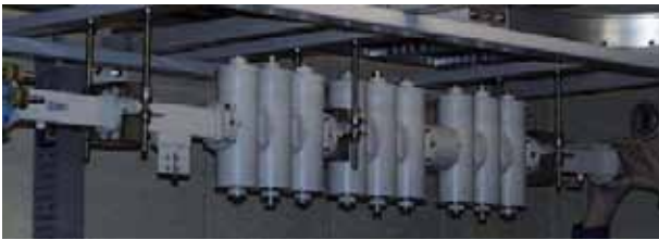
図 33 レーダサイトに実装された C 帯狭帯域フィルタ
